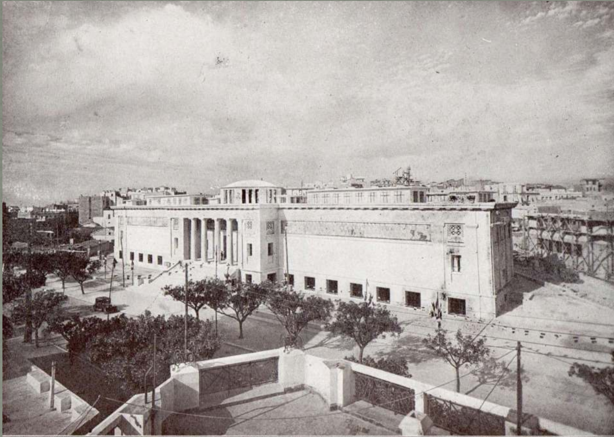
Oran : Le Palais des Beaux-Arts : Façade principale.
